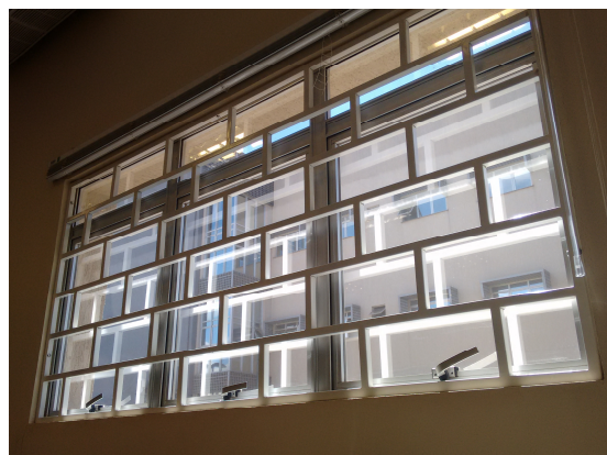
Figura 02 - grade de proteção tipo tijolo intertravado..
